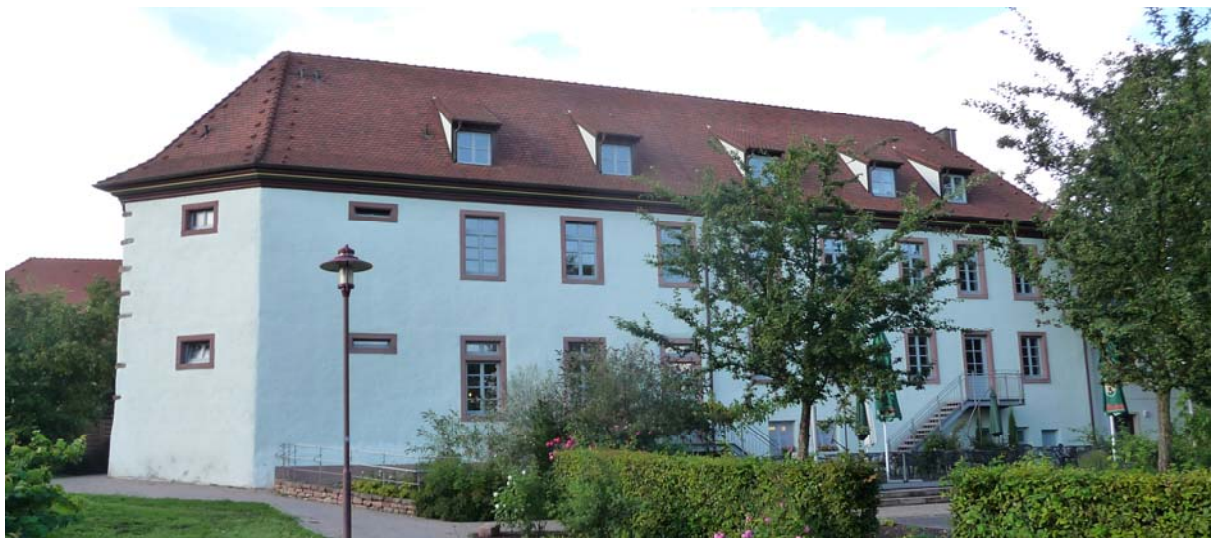
Stättlicher Rest der ehemaligen Schlossanlage: Der heute als Dorfgemeinschaftshaus genutzte „Edelhof“ mit Gartenanlage
